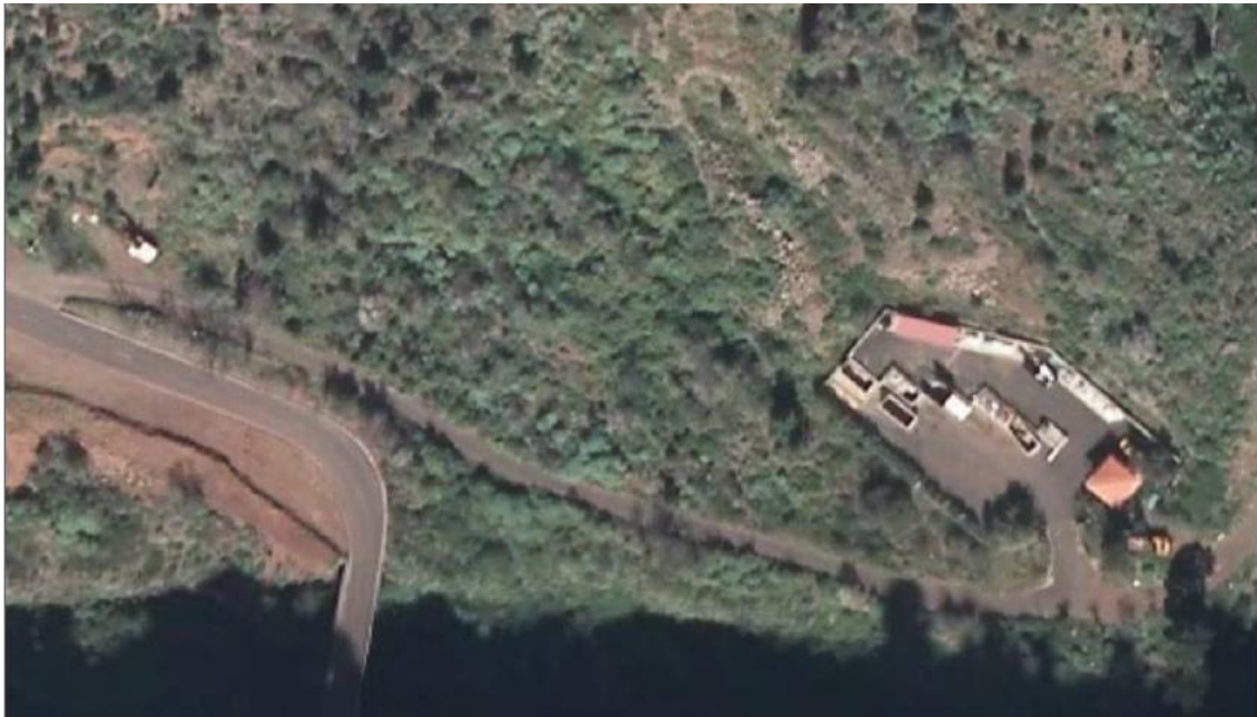
PANORÁMICA DEL PUNTO LIMPIO DE TIJARAFE Y ACCESO DESDE LA CARRETERA LP-1
