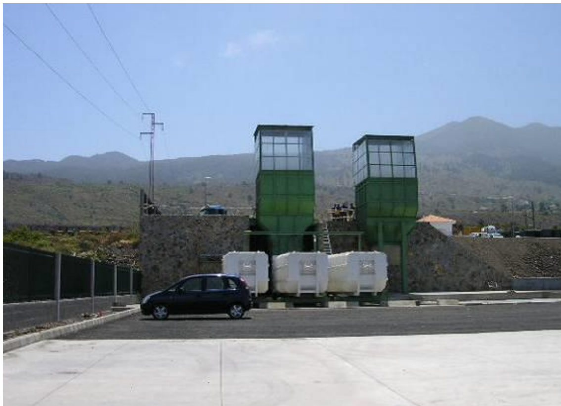
PLANTA DE TRANSFERENCIA DE RESIDUOS URBANOS T.M. DE LOS LLANOS DE ARIDANE
